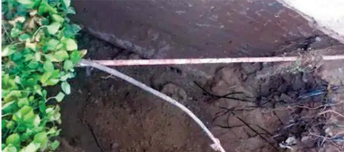
all'utenza Acea ha ricostruito il sistema fognario danneggiato, creando un bypass. Nel frattempo, il Csimu, per conoscere in maniera dettagliata le cavità presenti in prossimità della voragine e progettare l'intervento di riempimento in modo preciso, ha eseguito un rilievo laser scanner (georeferenziato). "Interventi come questo che abbiamo appena avviato a Tor de' Schiavi richiedono particolare attenzione e un preciso lavoro scientifico per l'elaborazione della mappatura e del progetto
